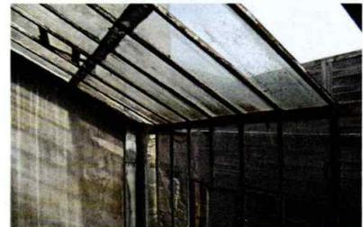
Cour avant curetage
